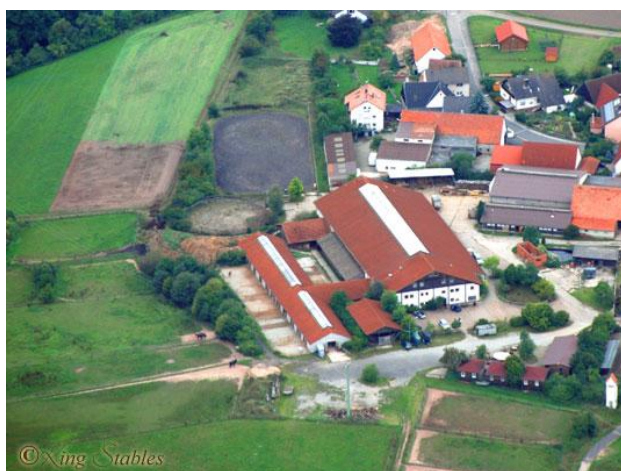
Anlage von oben
