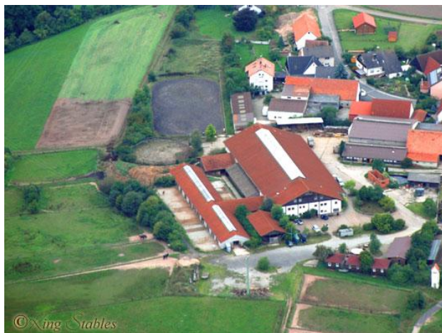
Anlage von oben
